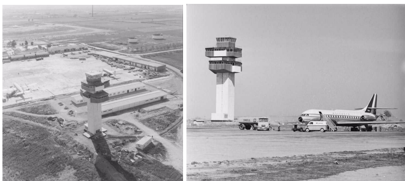
Antiga torre de control de Barcelona el Prat i ara oficines de Norwegian.
