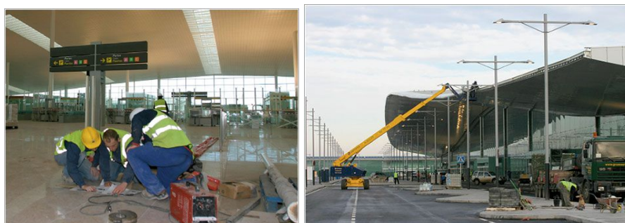
Terminal 1 en període de construcció abans del 2009.
