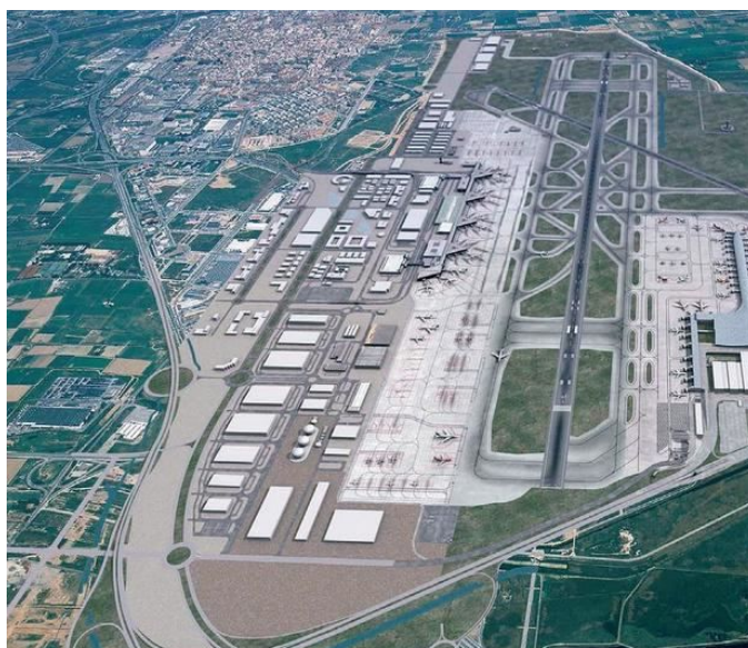
Imatge artificial de com seria l'aeroport amb les reformes acabades.
